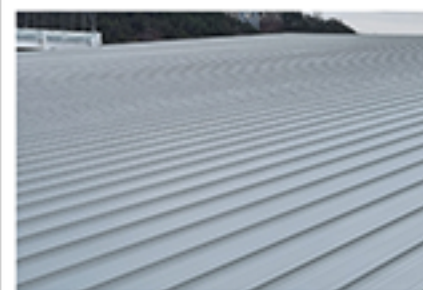
특수지붕재 시공 완료
