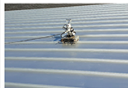
지붕 상부 패널 거멀접기 심 작업
