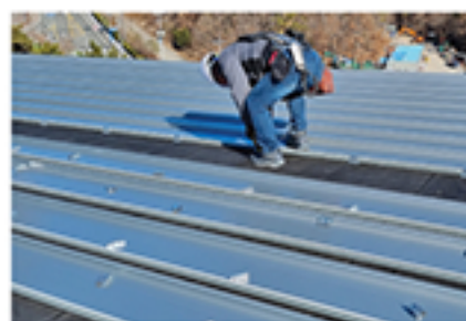
지붕 상부 패널 슬라이딩 클립 고정
