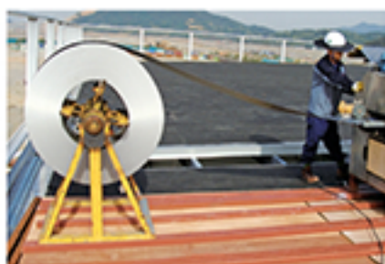
지붕 상부 패널 생산 및 EPDM 부착
