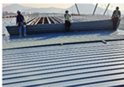
하부 베이스패널 설치
