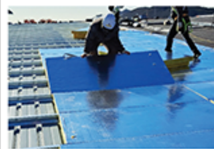
그라스울 단열재 설치
