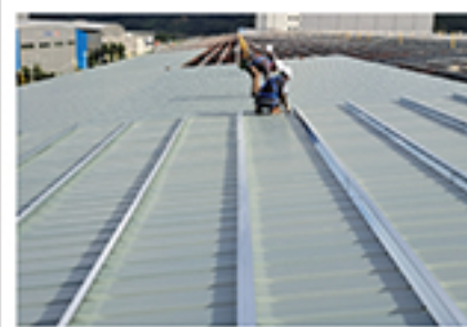
구조연결부 설치 및 체결
