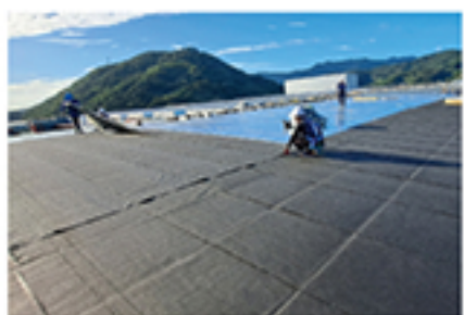
단열재 결로방지시트 설치
